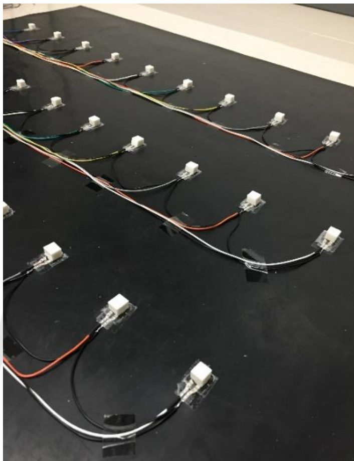
ภาพประกอบ 15 ตัวอย่างการติดตั้งจุดรวมแรงบนเซ็นเซอร์แรงกด
