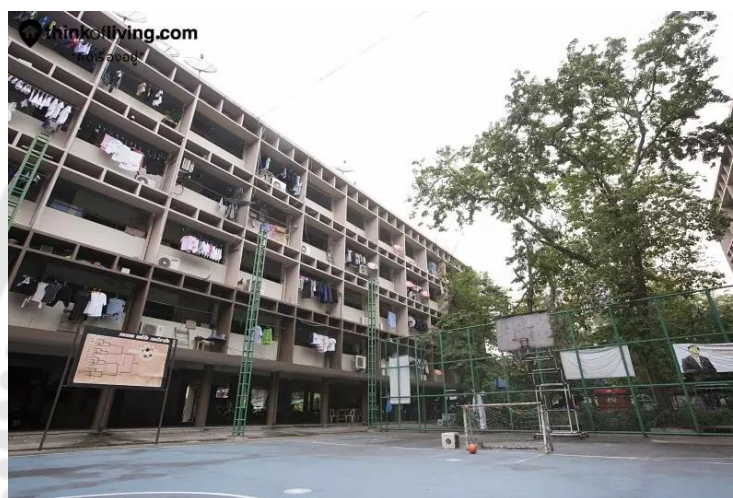
ภาพประกอบ 1 สภาพแฟลตดินแดงก่อนการรื้อถอน
