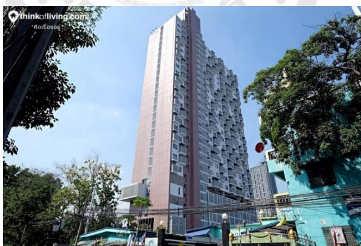
ภาพประกอบ 2 อาคารแปลง G ชุมชนดินแดง ระยะที่ 1
