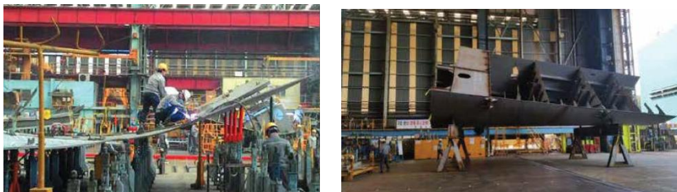
ภาพประกอบ 16 ขั้นตอนการประกอบบล็อก (Block Fabrication)
