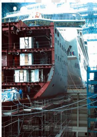
ภาพประกอบ 3 การประกอบต่อรวมกันเป็นบล็อกตัวเรือ (Hull Fabrication Block)
