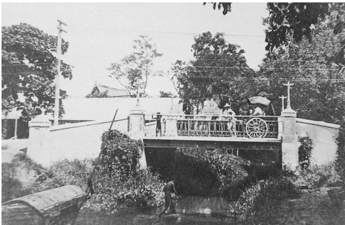
ภาพประกอบ 16 ลักษณะสะพานที่เอื้อต่อการเดินทางทางบกในภาพคือสะพานเฉลิมยศ 45
