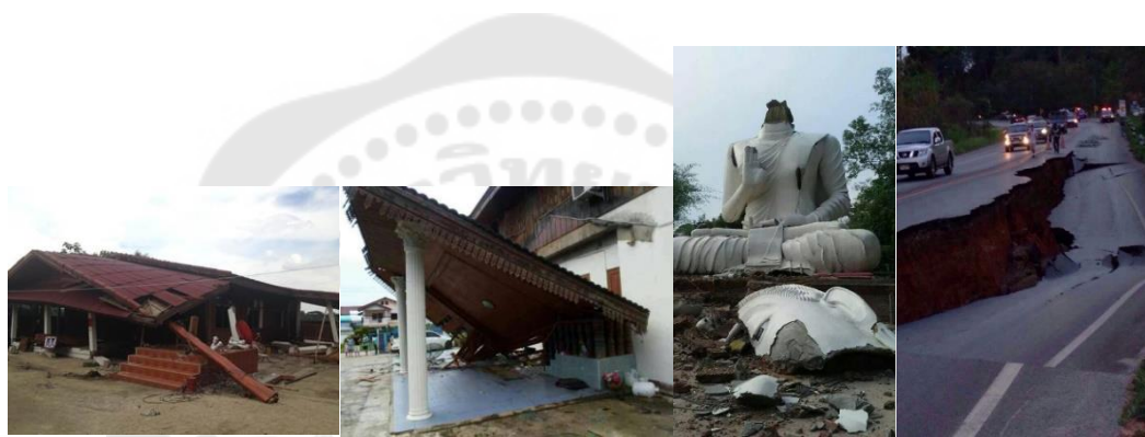
ภาพประกอบ 7 ความเสียหายที่เกิดขึ้นจากเหตุการณ์แผ่นดินไหว
