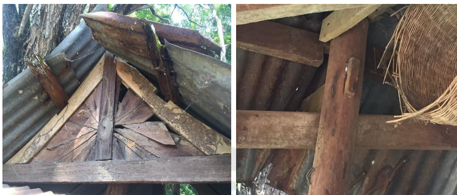
ภาพประกอบ 6 ลักษณะการเข้าไม้แบบดั้งเดิมฝีมือชาวบ้านไทญ้อที่ยังสามารถเห็นได้จาก โครงสร้างหอสงฆ์น้ำพระหลังเก่าที่วัดสุทธาวาส
