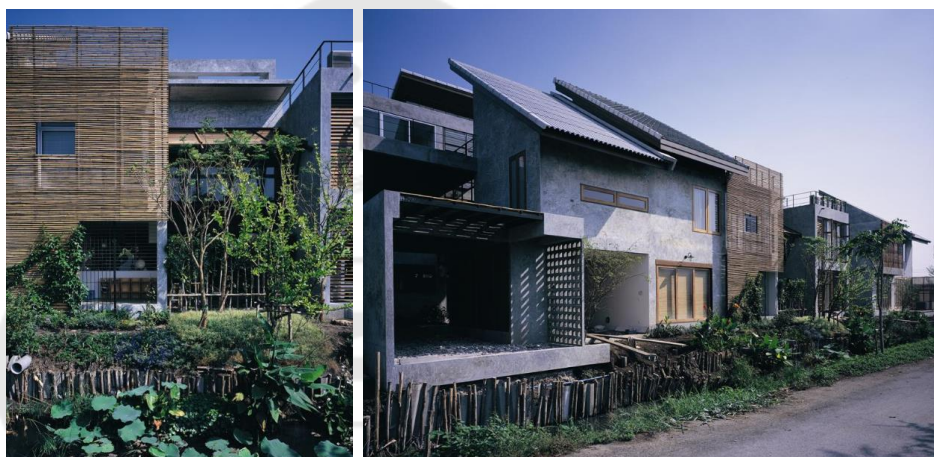
ภาพประกอบ 71 แสดงผลงานสถาปัตยกรรมด้านหน้าอาคาร
