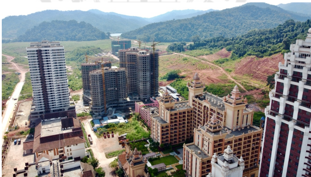
ภาพประกอบ 6 การก่อสร้างอสังหาริมทรัพย์ในเมืองบ่อเต็น
