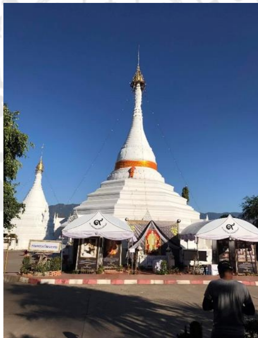
ภาพประกอบ 11 พระบรมธาตุดอยกอกมู
