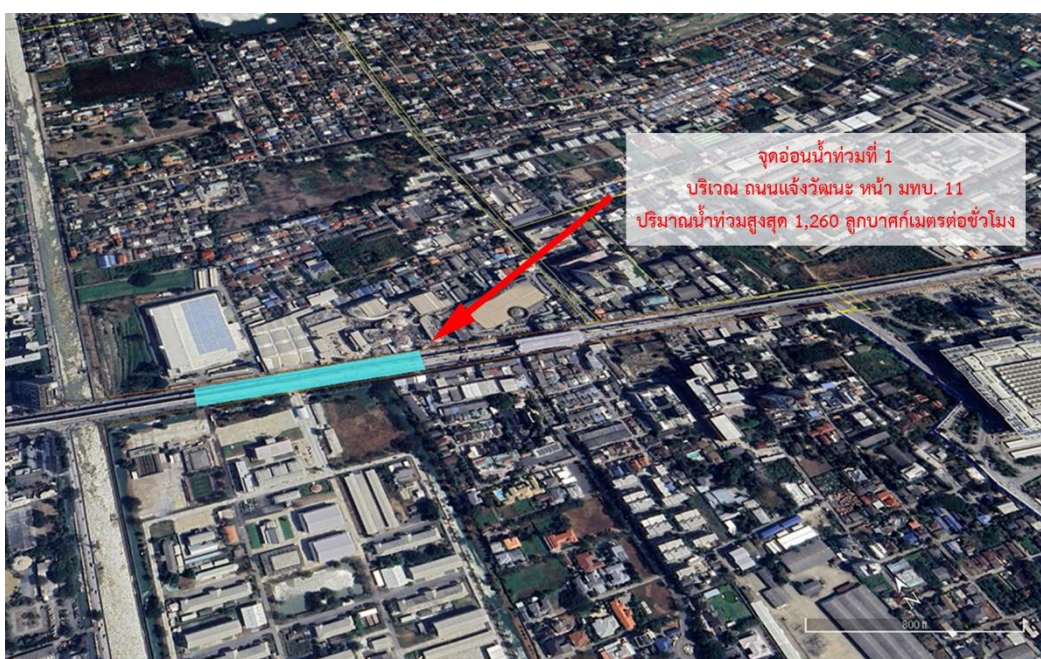
ภาพประกอบ 44 พื้นที่จุดอ่อนน้ำท่วมบริเวณถนนแจ้งวัฒนะ หน้า มทบ.11
