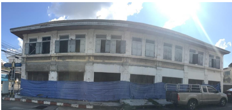
ภาพประกอบ 68 อาคารหมายเลข W3 ถนนสถิตยนิมานกาล
