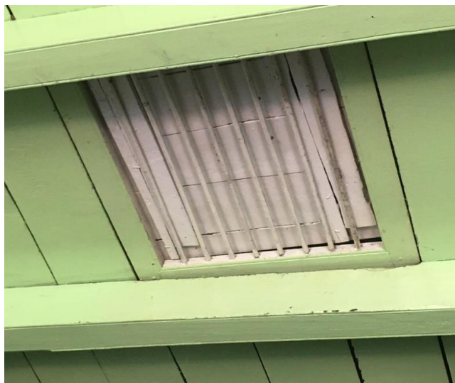
ภาพประกอบ 14 ช่องเปิดปิดบนเพดานระหว่างชั้นบนกับชั้นล่าง ใช้ในการส่งสินค้าขึ้นลงที่ร้านพรจิต ถนนหลวง
