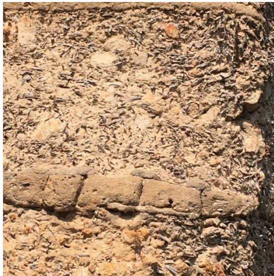
ภาพประกอบ 16 โครงสร้างผนังของตึกดิน ประกอบด้วยดินเหนียวผสมกับแกลบ
