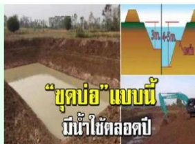
ภาพที่ 11 การขุดบ่อน้ำ
