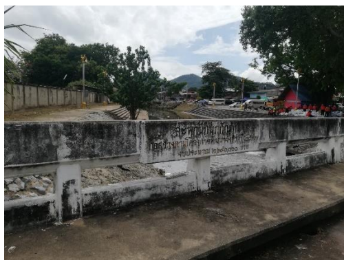
ภาพประกอบ 368 สะพานกุ่มภักดิ์สะท้อนวิถีคิดการเชื่อมโยงตัวละครจากนิทาน กับชื่อสถานที่ชุมชน
