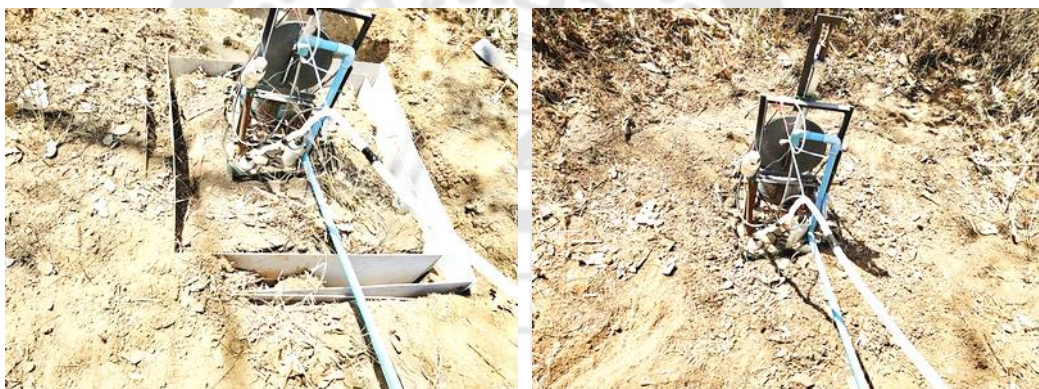
ภาพประกอบ 54 การวางแผนยิปซัม และกลบหลุม trenching
