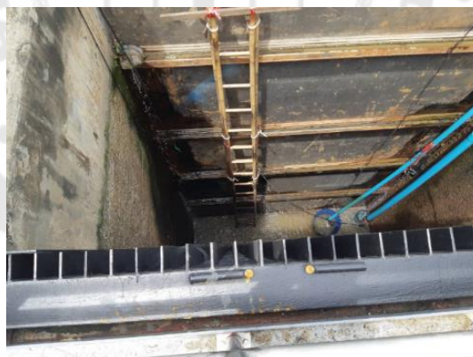
ภาพประกอบ 4 กำแพงหยาบสำหรับกรองวัสดุขนาดใหญ่
