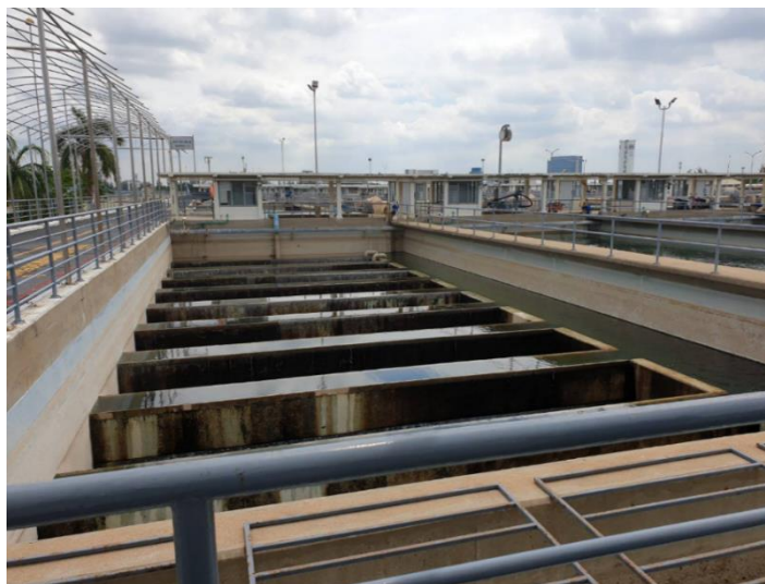
ภาพประกอบ 6 พื้นที่บริเวณบ่อกรองน้ำของโรงงานผลิตน้ำบางเขน
