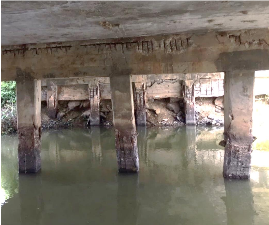
ภาพประกอบ 1 ลักษณะความเสียหายจากการเป็นสนิมของเหล็กเสริมคอนกรีต
