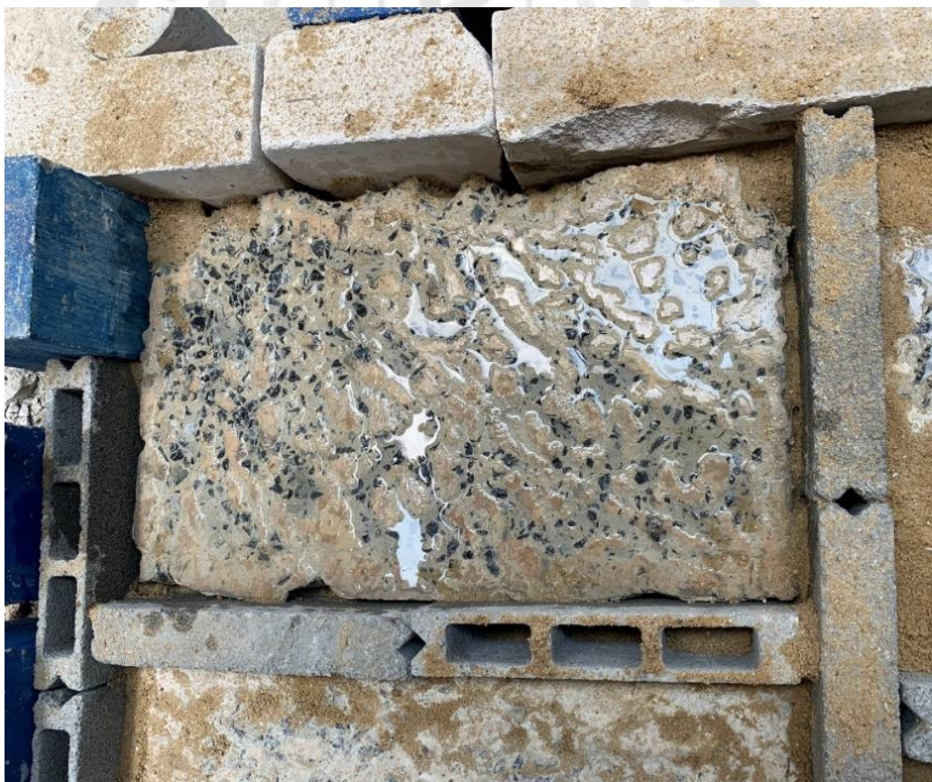
ภาพประกอบ 15 การเตรียมพื้นผิวคอนกรีตสำหรับงานซ่อมแซม
