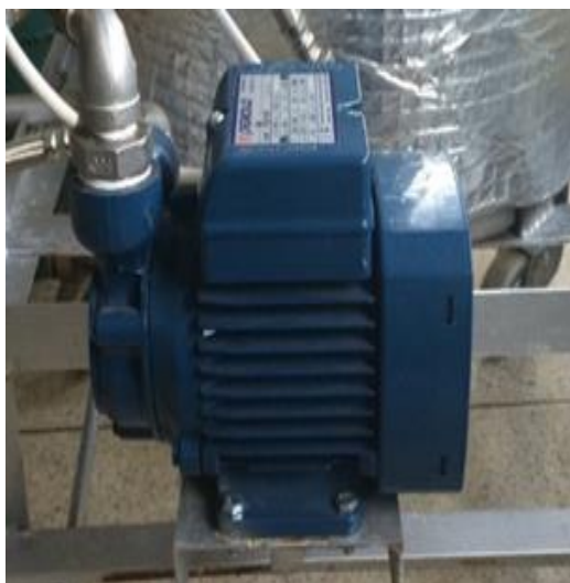
ภาพประกอบ 49 เครื่องสูบน้ำ (Water Pump)
