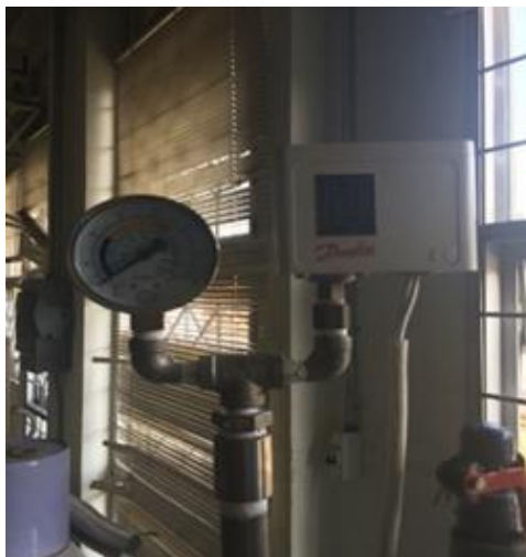
ภาพประกอบ 46 สวิตช์ควบคุมความดันและหน้าปัดแสดงความดัน
