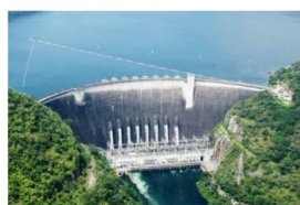
ภาพที่ 1.2 เขื่อนภูมิพลที่ก่อสร้างในรูปแบบเขื่อนคอนกรีตแบบโค้ง ที่มา : http://static.naewna.com/uploads/news/source/293017.jpg
