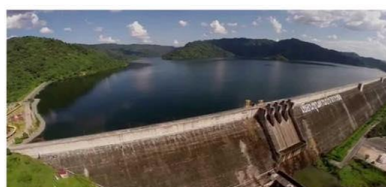
ภาพที่ 1.1 เขื่อนขุนด่านปราการชลที่ก่อสร้างในรูปแบบเขื่อนคอนกรีตแบบถ่วงน้ำหนัก ที่มา : http://thailandtopvote.com/wpcontent/uploads/2017/01/%E0%8A%E0%B8%A5-4.jpg
