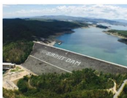
ภาพที่ 1.4 เขื่อนสิริกิติ์ จังหวัดอุตรดิตถ์ ก่อสร้างในรูปแบบของเขื่อนดิน
